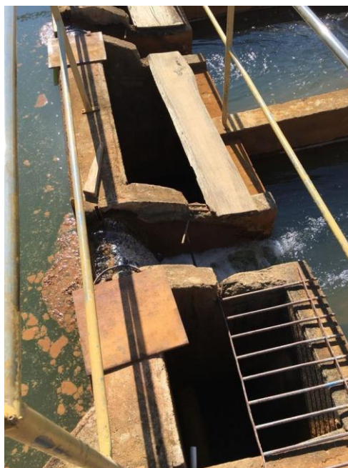
Fotografia 9 - Final do reservatório decantador
