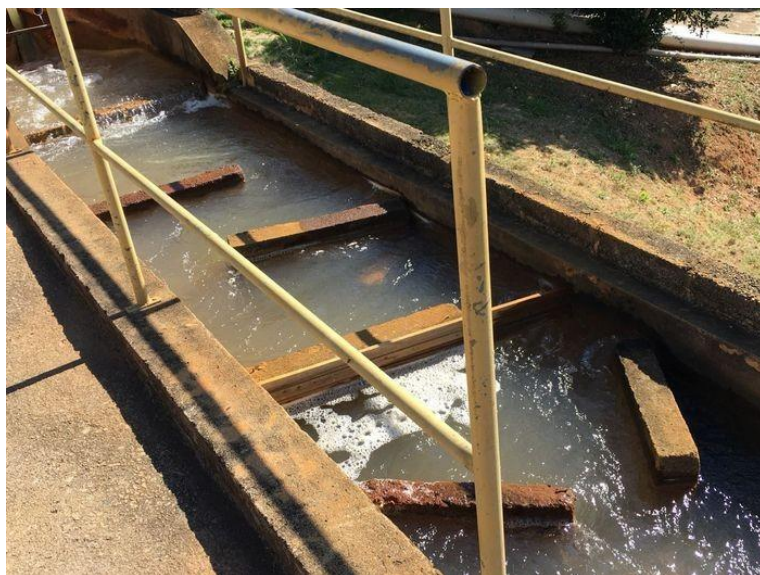
Fotografia 4 - Movimento de serpenteamento até as chicanas
