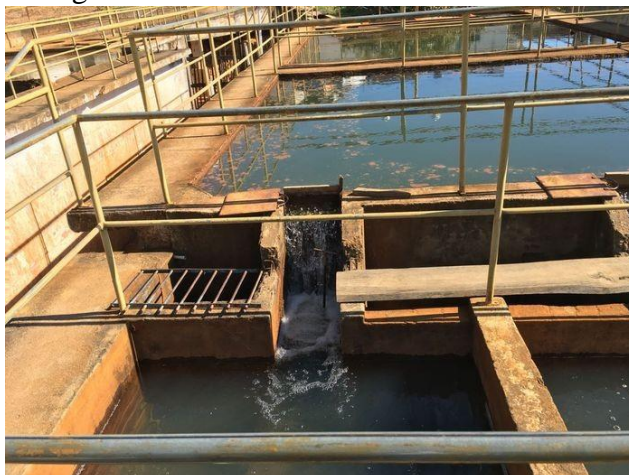
Fotografia 10 - Final do reservatório decantador
