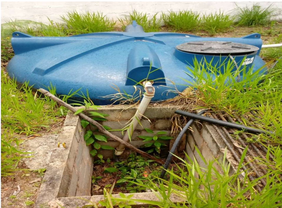
Figura 8- Ponto de distribuição da água não tratada recebida por parte dos moradores do bairro Cidade Alta - RJ
